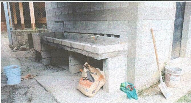
Foto 5: MEJORAMIENTO DE LAVAMANOS
